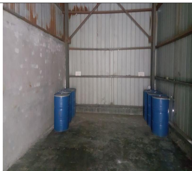
图 4-5 危废库房（内部）
