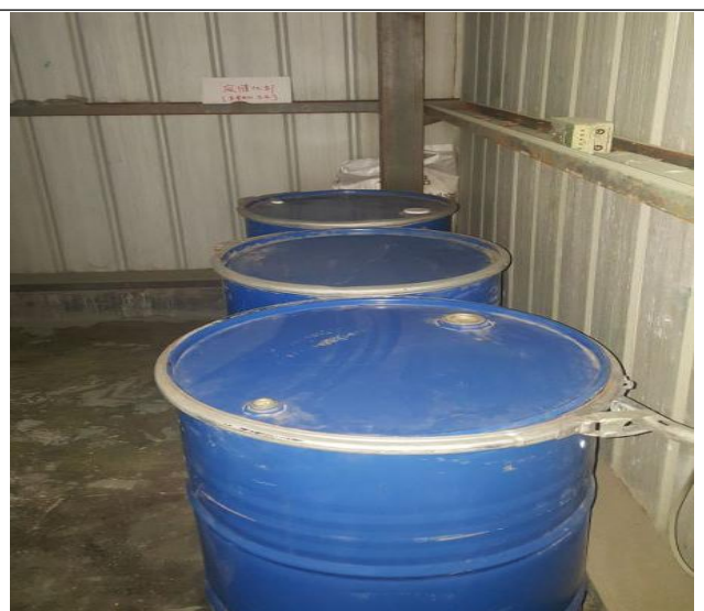
图 4-17 危废库房（内部）
